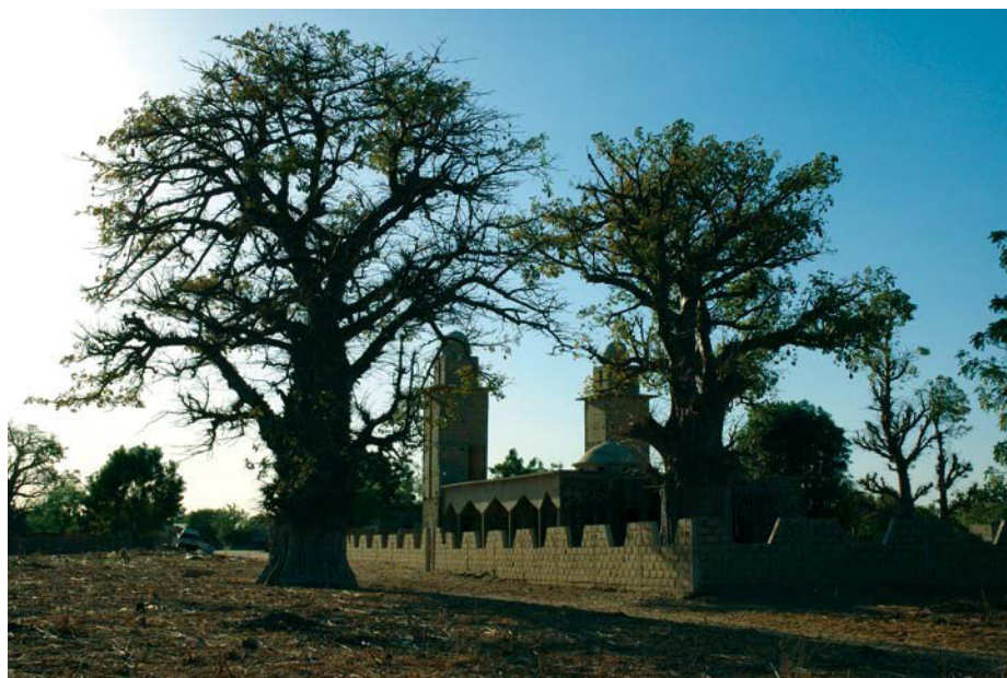
Deux majestueux baobabs surplombent la mosquée en construction.
